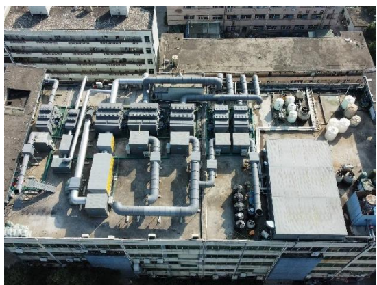
楼顶改造后航拍图
