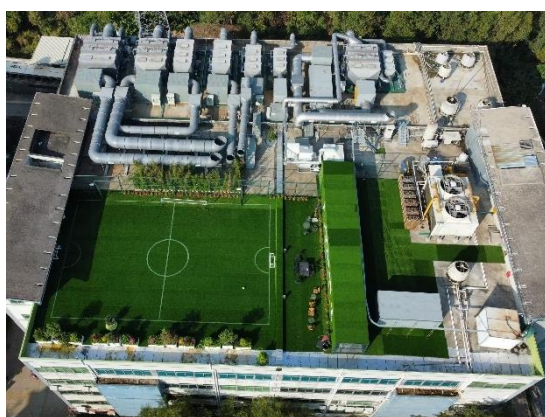
楼顶改造后航拍图
