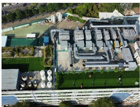
楼顶改造后航拍图
