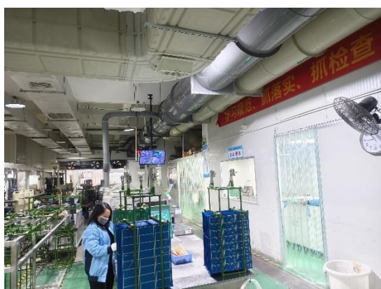
陶瓷板清洗线废气收集
